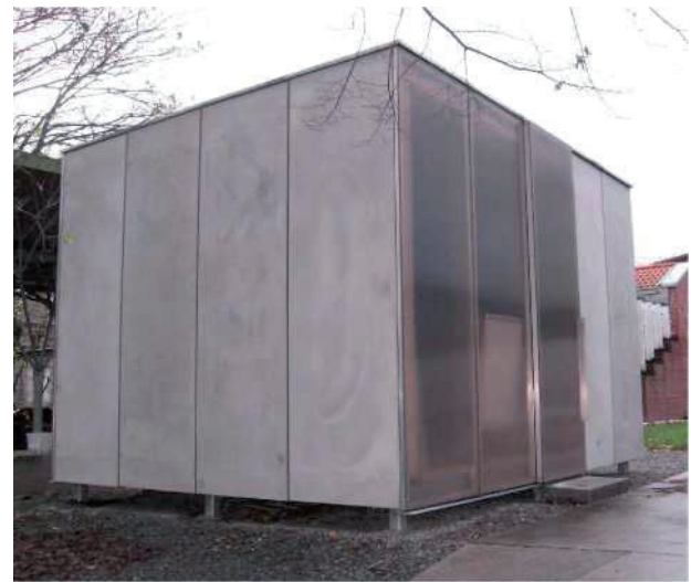
Rys. 9. Kawiarenka studencka wykonana z elementów warstwowych z betonu zbrojonego tkaniną
