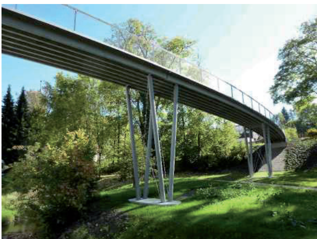
Rys. 10. Kładka dla pieszych z betonu zbrojonego tkaniną
